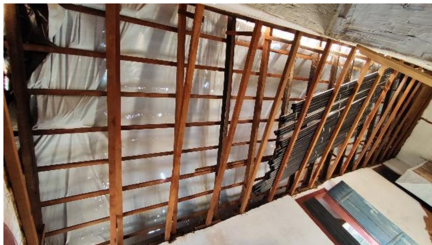
Intervenção no telhado da capela lateral Autoria: Francielle Ferreira Data: 21/05/2024
