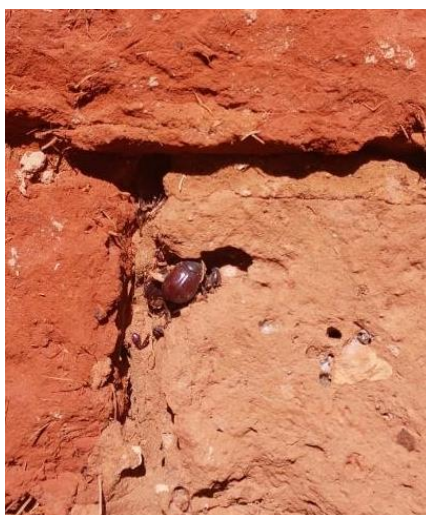
Remoção do reboco das alvenarias externas
